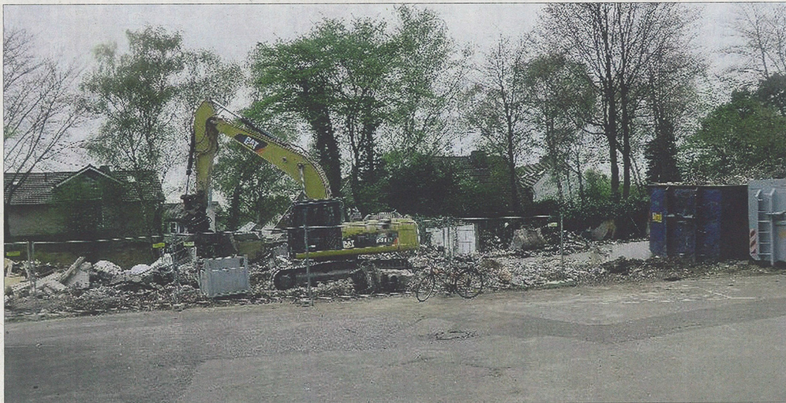
Das Gelände des Kinderkrankenhauses, auf dem früher die Ärzte-Häuser standen soll in Kürze neu bebaut werden. Die Bagger sind schon angerückt. (Fotos: Krick)
